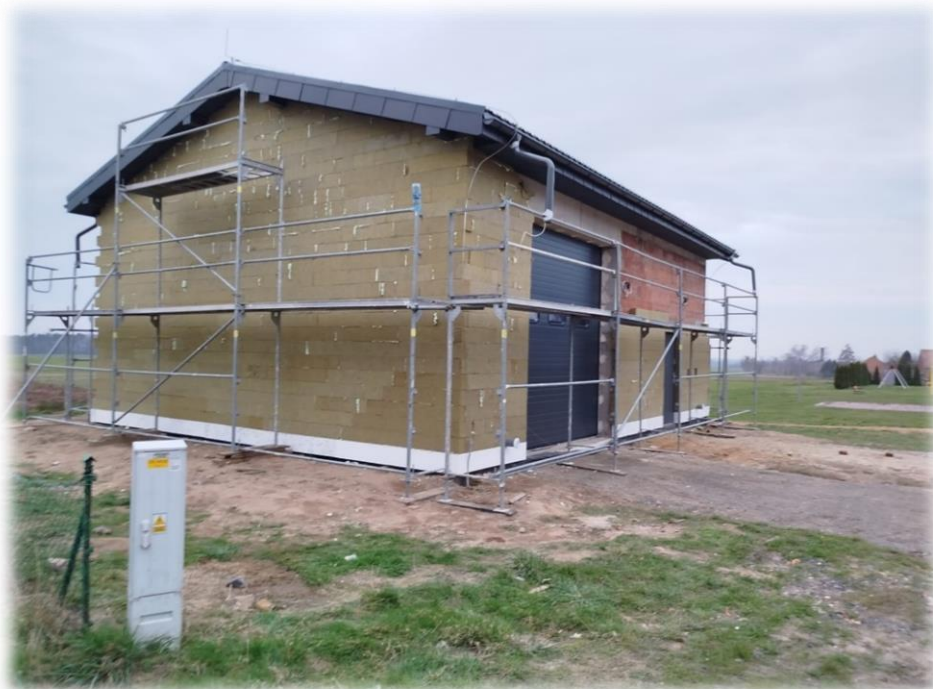
4. Przebudowa i rozbudowa garażu jednostki OSP Kobyla Góra - Pakoszów Kwota brutto: 307.590,00 zł
