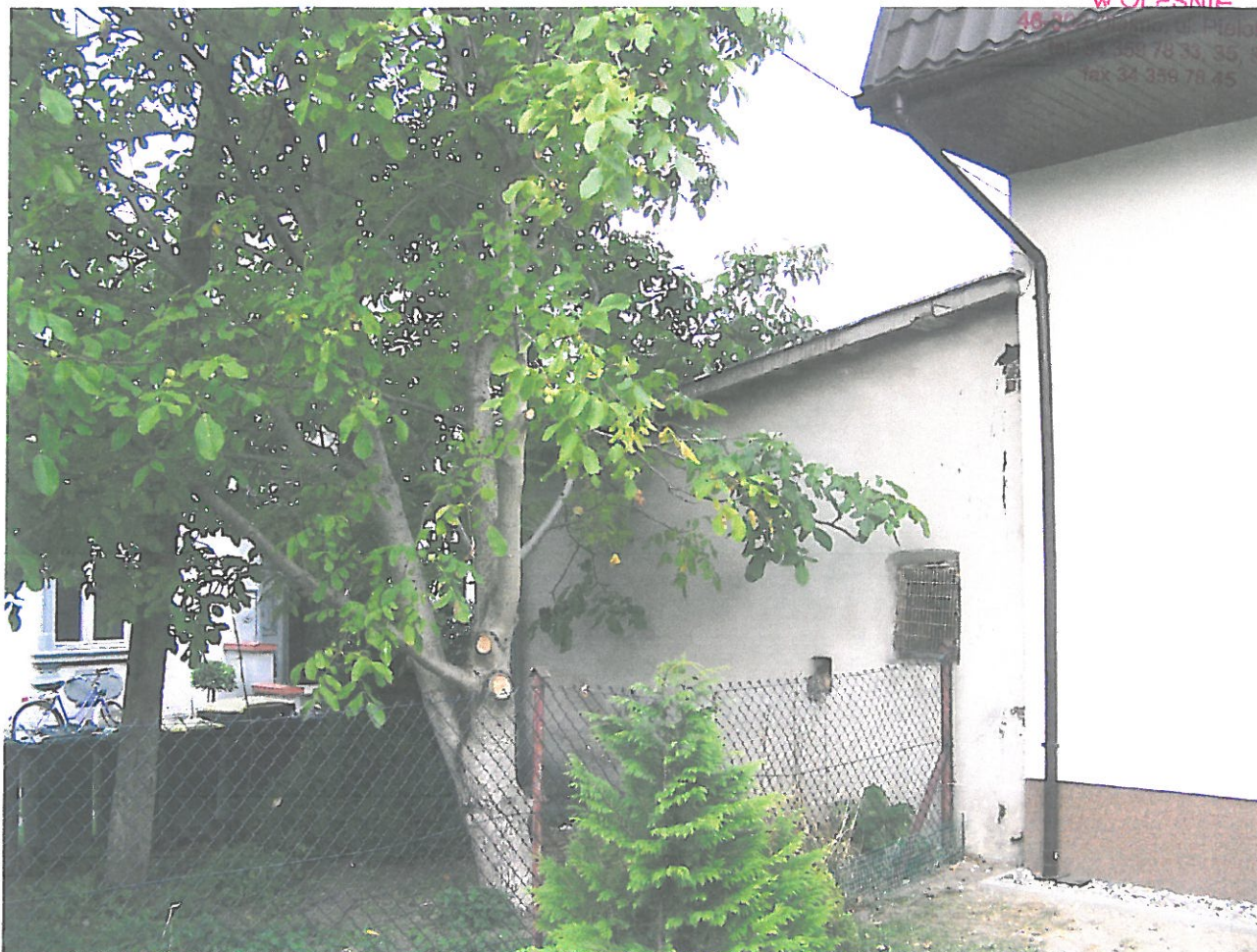
Fot. nr 1. Elewacja południowa
