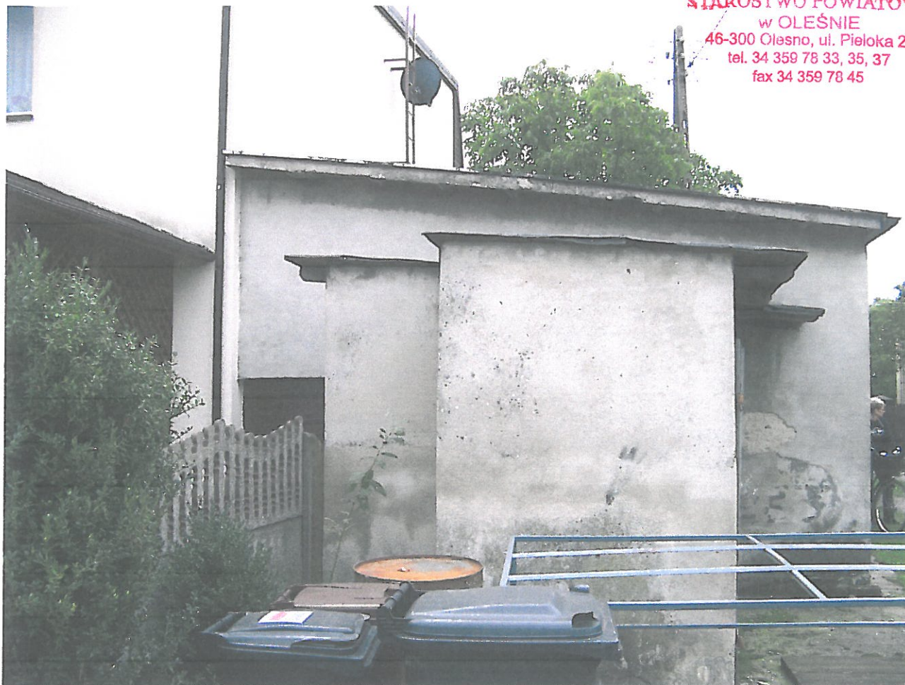
Fot. nr 3. Elewacja północna
